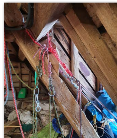
Le dispositif d'assurage mis en place pour les descentes
